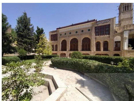
تصویر ۲: ساختمان شاه نشین
