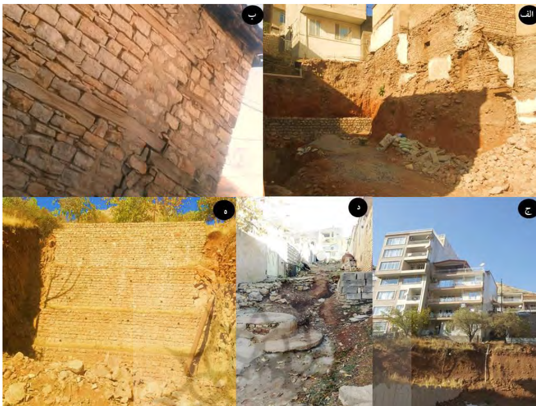
شکل ۴. الف) خاک‌برداری‌های غیراستاندارد در بافت قدیمی (ب) ترک خوردگی دیوارهای خانه‌های قدیمی (ج) بلندمرتبه‌سازی در شیب‌های غیراستاندارد (د) ایجاد آب‌بند در محلات بالادست دره باسَم (ه) ایجاد دیوار حائل ۸ متری و افزایش هزینه ساخت‌وساز
