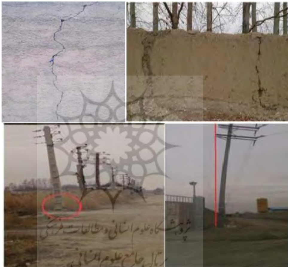
شکل ۱۱: ایجاد ترک و کج شدگی خطوط انتقال برق (حبیب زاده و همکاران، ۱۳۹۲، ۶۴)
