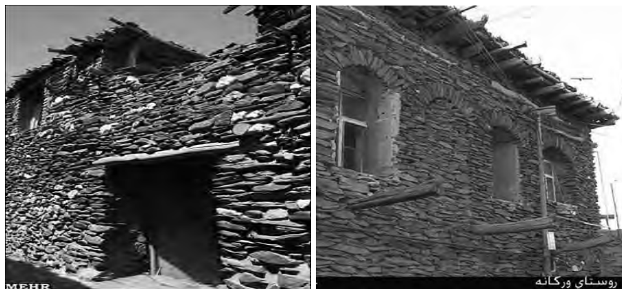
تصویر ۱۲: تورفتگی در بازشوها به منظور سایه‌اندازی. (مأخذ: link2)
