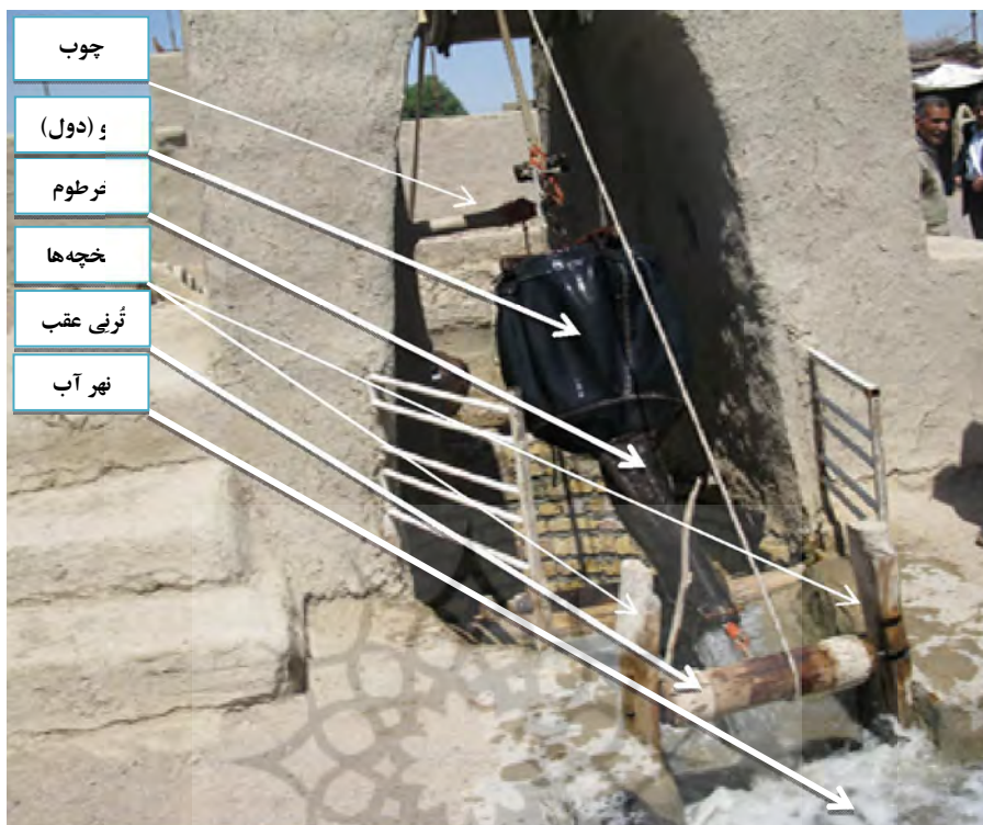
عکس ۷- اجزا و عناصر سحیل‌دهنده ساچاه در ساچاه حاج ابراهیم (رورنه)
