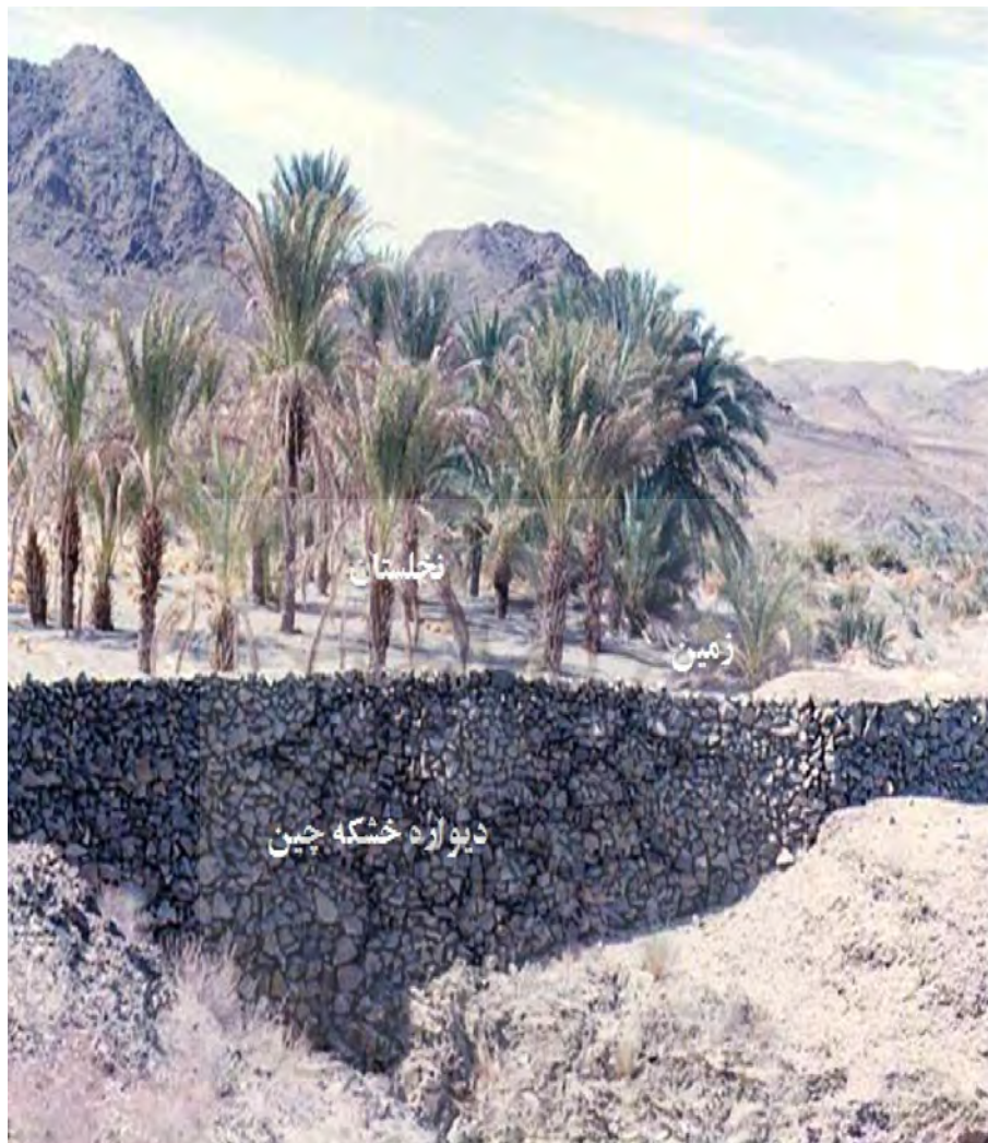
عکس ۳- نمونه‌ای از خوشاب با دیواره خشکه چین سنگی حاشیه رودخانه
