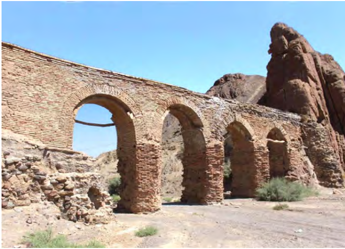
تصویر ۱۲: پل آب‌بر خرائق. نمونه‌ای از سازه پل که به منظور انتقال آب ساخته شده است.
