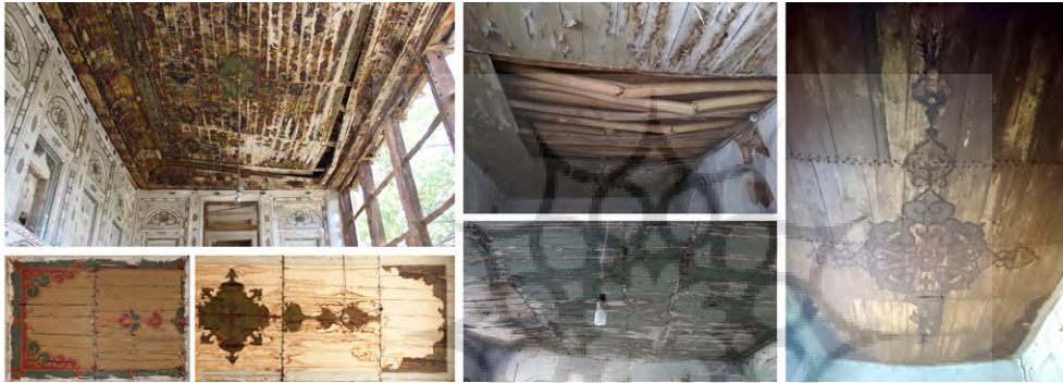
تصویر ۲: تخته کوبی (توفال کوبی) ساده با تزیینات زیبای نقاشی چوبی در خانه‌های ۱، ۲، ۴ و ۷
