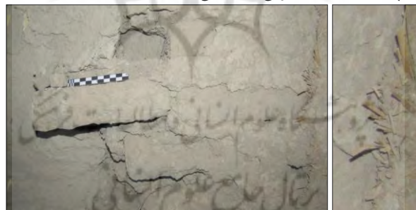
شکل ۱۴: خشت و ملات کاهگل دیوار (نگارنده)
