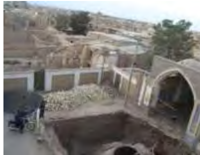
ضلع غربی حوضخانه از نمای جنوبی
