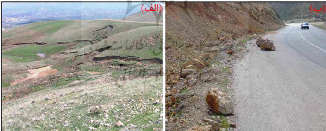
شکل ۵: لغزش‌های تحریک شده در اثر زلزله (الف) جاده بروجرد به کولیدر، (ب) جاده بروجرد به خرم‌آباد
