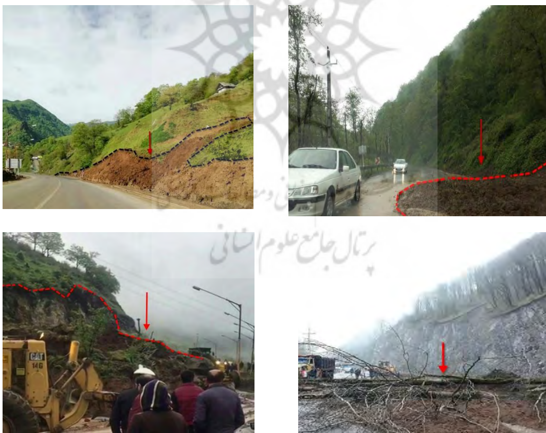
شکل ۷. نمونه‌هایی از زمین‌لغزش‌های اتفاق افتاده در مسیر مواصلاتی حیران به سمت آستارا و بسته شدن مسیر ارتباطی
