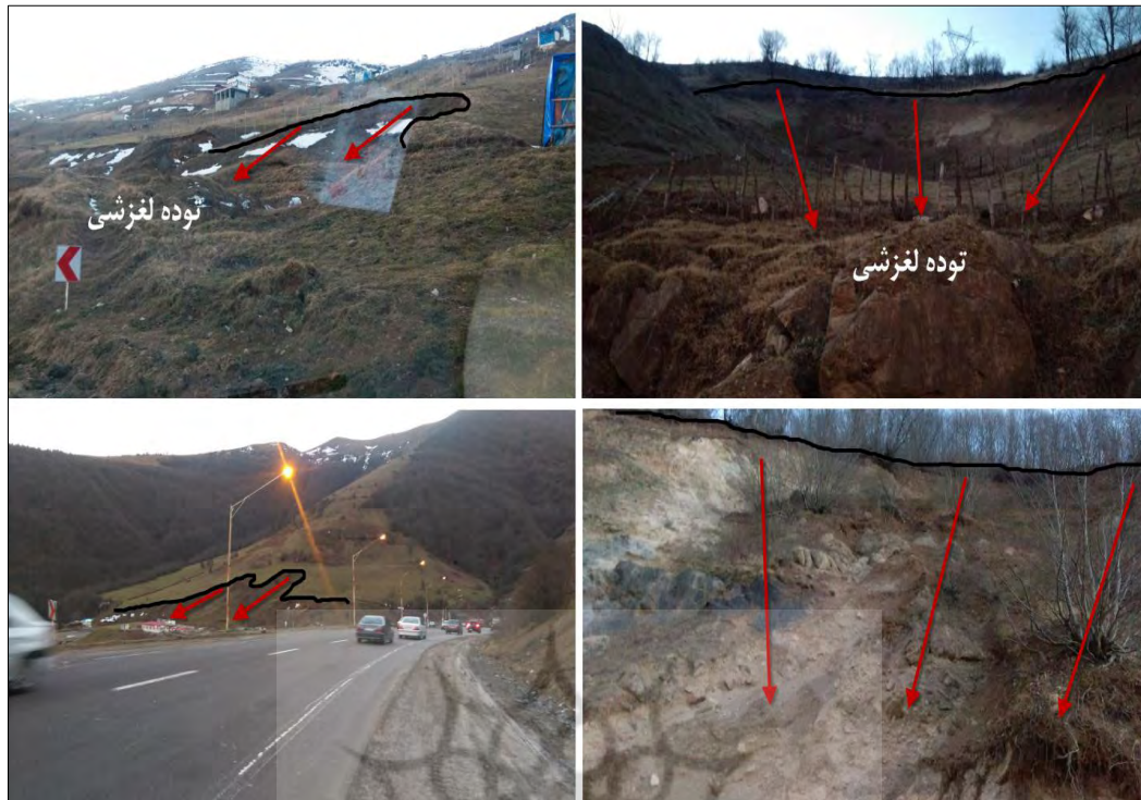
شکل ۶. زمین لغزش‌های اتفاق افتاده در مسیر محور حیران - آستارا
