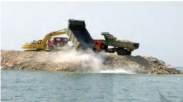
شکل شماره ۳: پر کردن دریا بوسیله مواد سنگی - خاک و بلوکهای سیمانی (اسکله) (همان)
