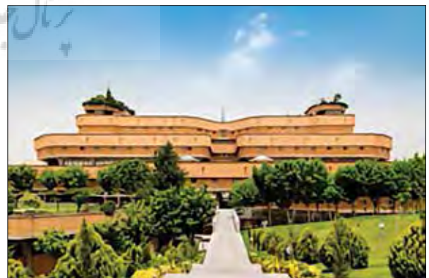
تصویر ۴: نمای خارجی کتابخانه ملی (منبع: www.nlai.ir) Figure 4: Exterior view of the National Library (Source: www.nlai.ir)
