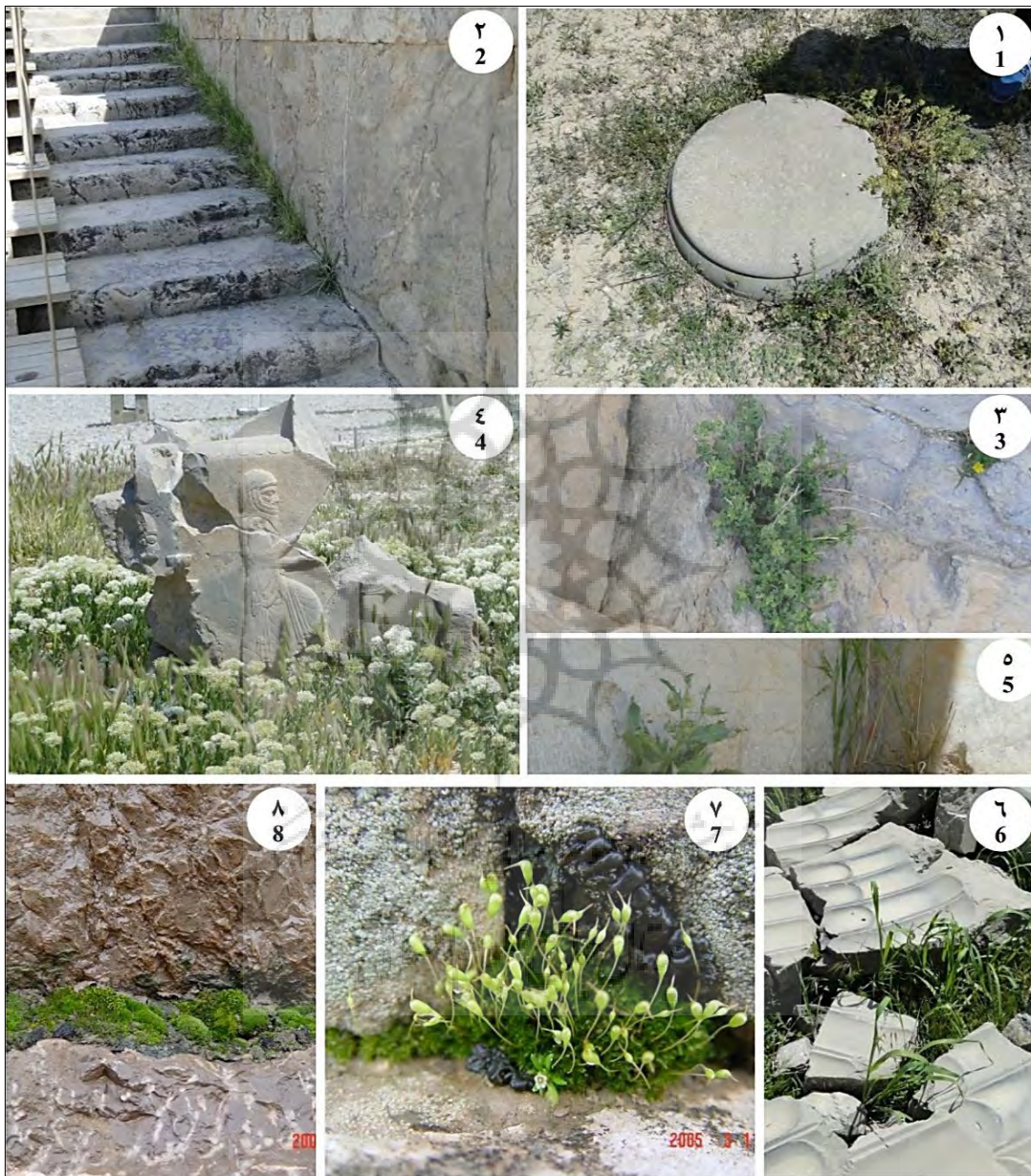
شکل ۲. نمایی از فرسودگی زیستی در بخش‌های مختلف تخت جمشید توسط گیاهان؛ ۱) پایه ستون مربوط به یکی از ستون‌های کاخ خزانه‌داری؛ ۲) پلکان‌های ورودی؛ ۳) گیاهان روی دیوار پلکان ورودی؛ ۴) محوطه شمالی کاخ H؛ ۵) گیاهان اطراف کاخ تچر؛ ۶) گیاهان یک‌ساله اطراف کاخ صد ستون؛ ۷) خزه‌های کاخ دال؛ ۸) خزه‌های روی سنگ‌های محوطه کاخ آپادانا
