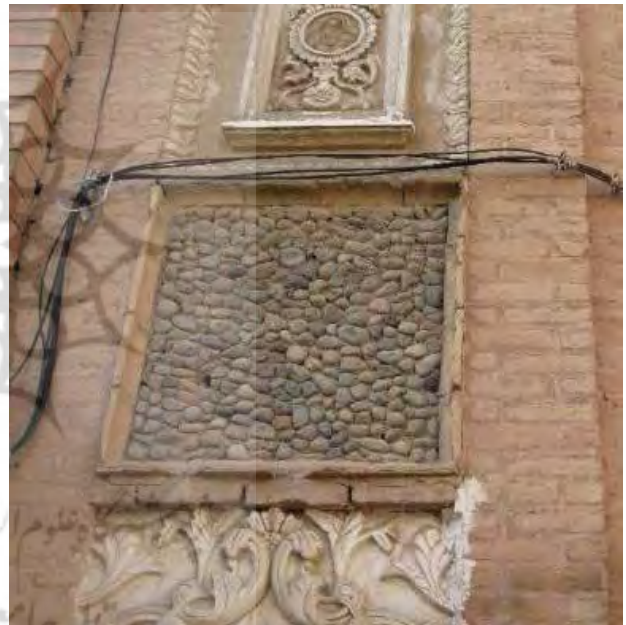
تصویر ۴. سنگ رودخانه‌ای به کار رفته در بخشی از نمای خانه شربت‌اوغلی تبریز. عکس: سمیه جلالی میلانی، ۱۳۹۵.
