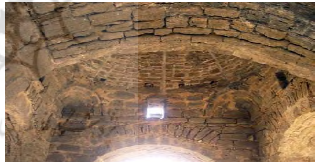
شکل ۹- شیوه پوشش چهارطاقی نیاسر با کمک توپزه گچی (مأخذ: رضایی‌نیا، ۱۳۹۷: ۱۴۵)
