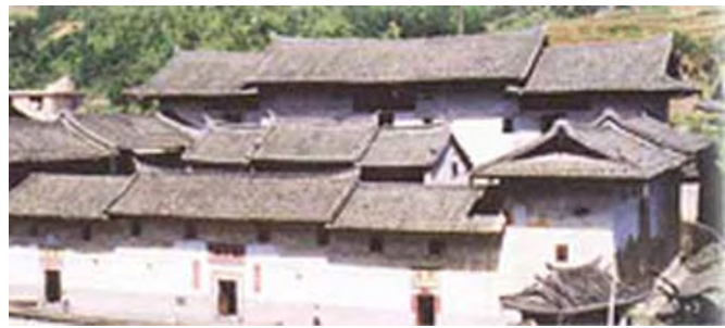
تصویر ۶- تالو پنج ققنوس با پلان مستطیل شکل در منطقه یونگ دینگ در ایالت فوجیان، چین. این خانه ها نیز مانند نمونه های مدور دارای ساختمان میانی هستند و ساختمان میانی به سالن نیاکان اختصاص دارد. (مأخذ: Knapp, Ronald G, 1989)
