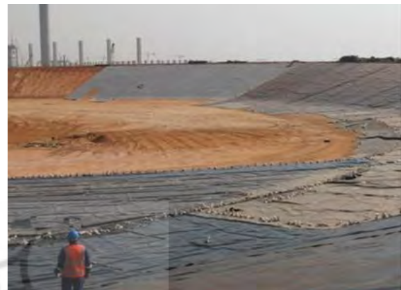
شکل ۴- مصالح پلیمری ژئوتکستایل در سدهای خاکی (منبع: https://geotextile.ir )
