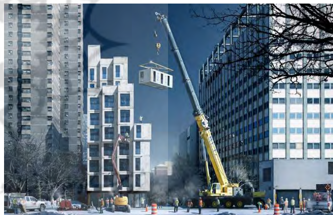
تصویر ۴: مونتاژ برج کارمل پلیس در محل منبع: (Mears&Ruth.2019)
