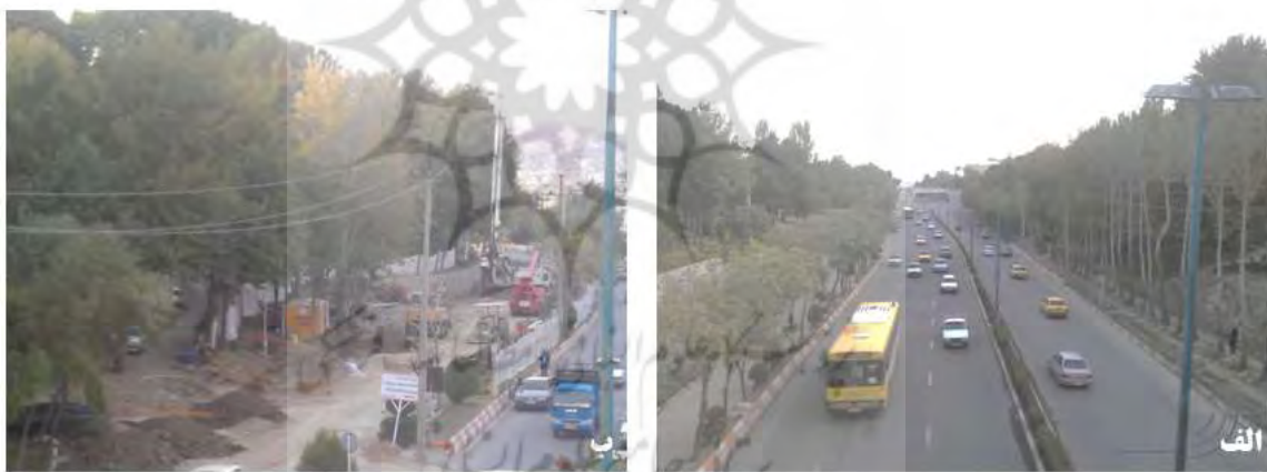
تصویر ۳- الف- گسست روابط فضایی پارک در اثر سرعت بالای حرکت خودروها در بلوار پاسداران و زیرگذر شالمان در جنوب محدوده، ب- عملیات احداث زیرگذر ضیاء الدینی- مأخذ: نگارندگان، ۱۳۹۰
