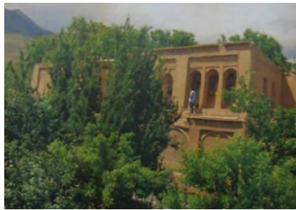
شکل ۴: درختان حیاط در قسمت جنوب بنا
