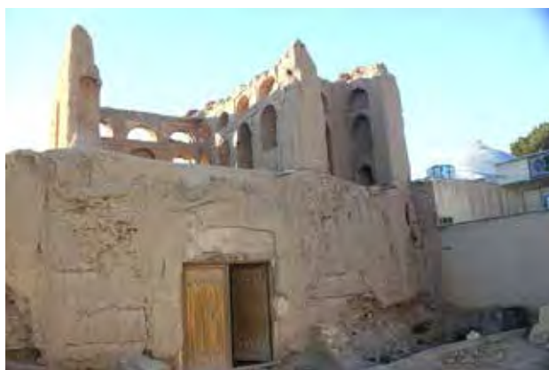
تصویر ۳. نمای شرقی بیرونی خانه بنی عامری. مأخذ: آرشیو نگارندگان، ۱۳۹۵.
