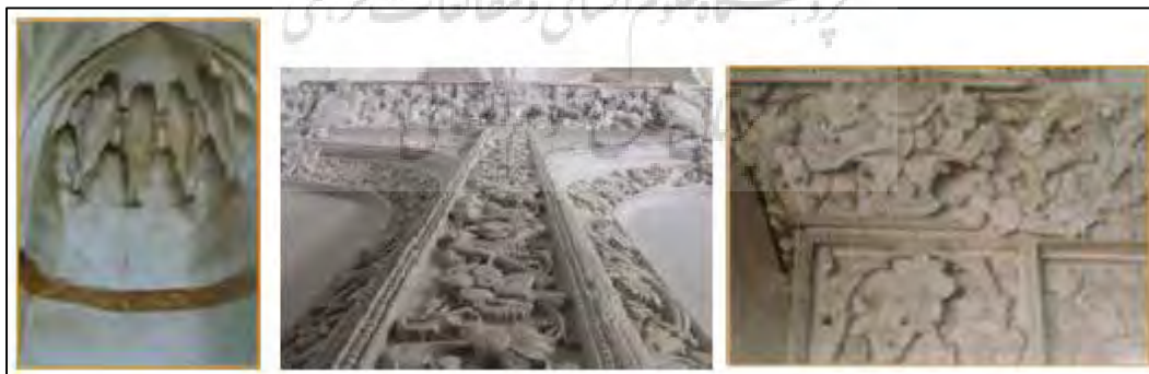
شکل ۲۵. پوشش سطوح داخلی
