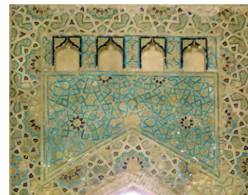
تصویر ۵: نمونه‌ای از تلفیق آجر و کاشی در ایوان‌های داخلی طبقه اول گنبد سلطانیه
