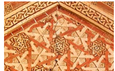
تصویر ۲۳: تلفیق دو گره «شش و شمسه» با تکنیک گچ‌بری و حمیل‌های رنگی، سقف ایوان‌های طبقه دوم
