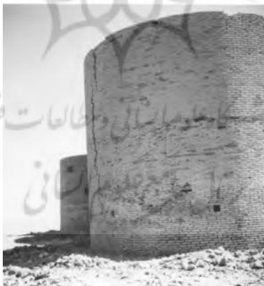
شکل ۹: استفاده از خشت و آجر در جزوه و تاق های کاروانسرا، راست: رباط زین الدین، یزد / چپ: رباط بیاض، کرمان (مأخذ: نگارندگان)
