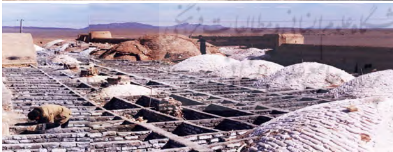
شکل ۱۳: پنام کاری سقف کاروانسرا و مسطح نمودن بام توسط مجوف کردن آن، بام کاروانسرای میاندشت، سمنان (مآخذ: میراث استان سمنان)
