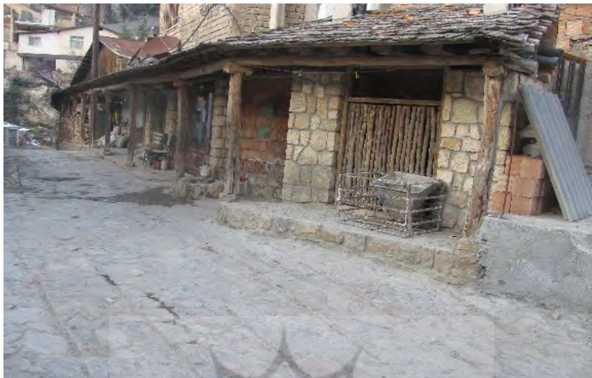
عکس ۱۲- اجرای تخته سر در پوشش بام
