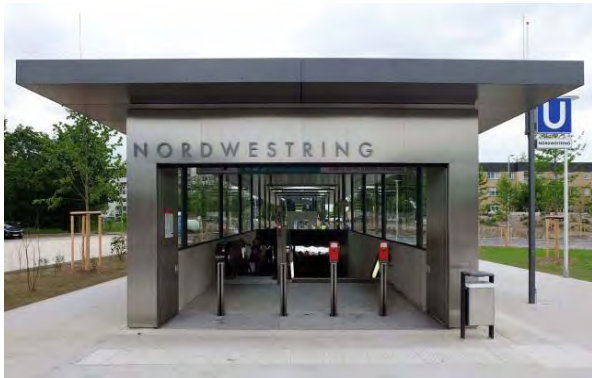
شماره ۷: ایستگاه شهر نورمبرگ، آلمان-مآخذ: www.muenchenarchitektur.com
