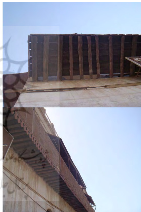
شکل ۳) امتدادیافتن چندل سقف در راستای ایجاد سازه‌ای برای کنسول شناشیر
