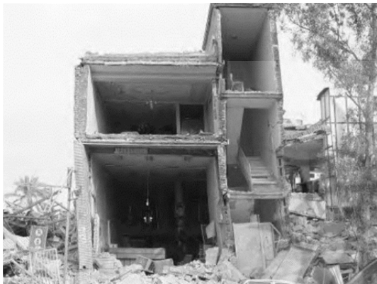
شکل ۵) فروپاشی خارج از صفحه‌ای دیوار؛ زلزله ۱۳۸۲ بم [25]
