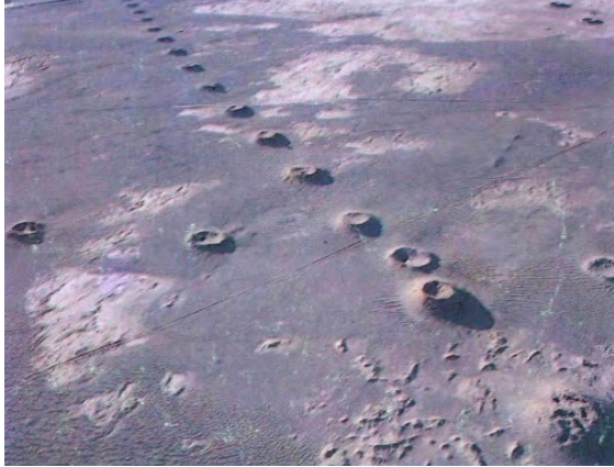
تصویر ۲: اجزاء شکل دهنده قنات جهت استحصال آب [۱۰]
