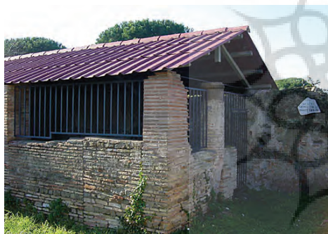
شکل ۲. نمای بیرون مهرابه.
