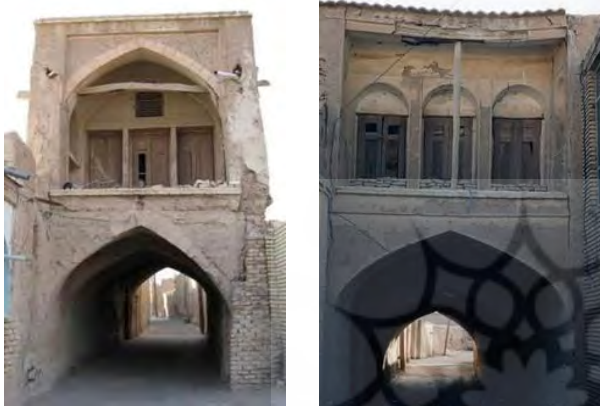
تصویر ۱۰- نمای دو ساباط در بافت تاریخی نایین ساخته شده با مصالح بومی منطقه خشت و ملات گل ((نگارنده))
