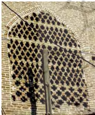
شکل ۷- طرح مشبک آجری پشت شبستان جنوبی
