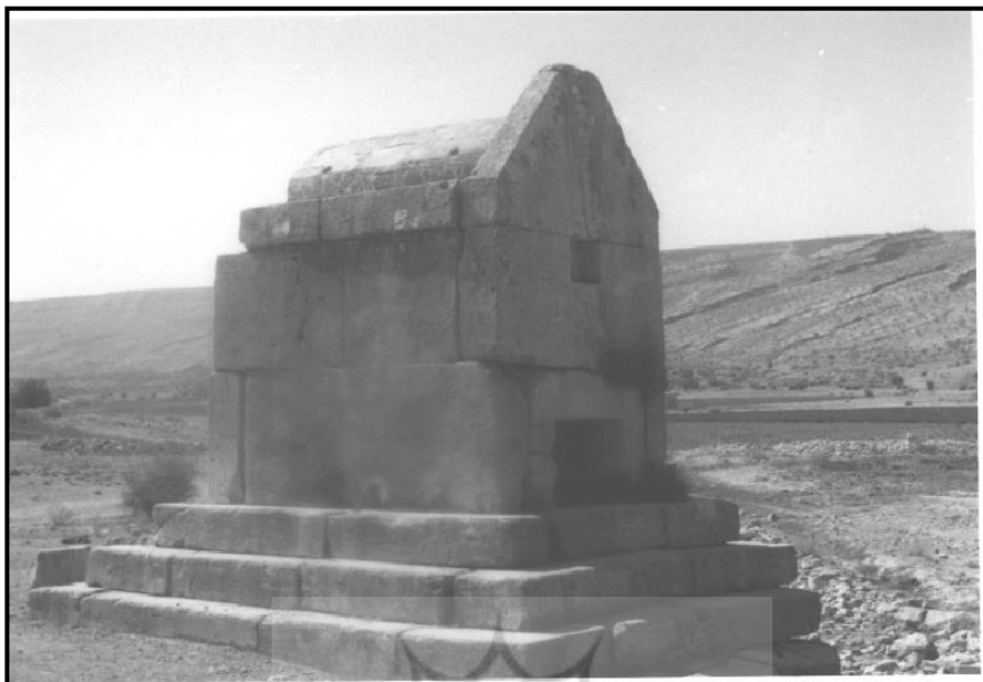
تصویر شماره ۲: نمای کلی از آرامگاه گوردختر قبل از مرمت، دید از شمال شرق
