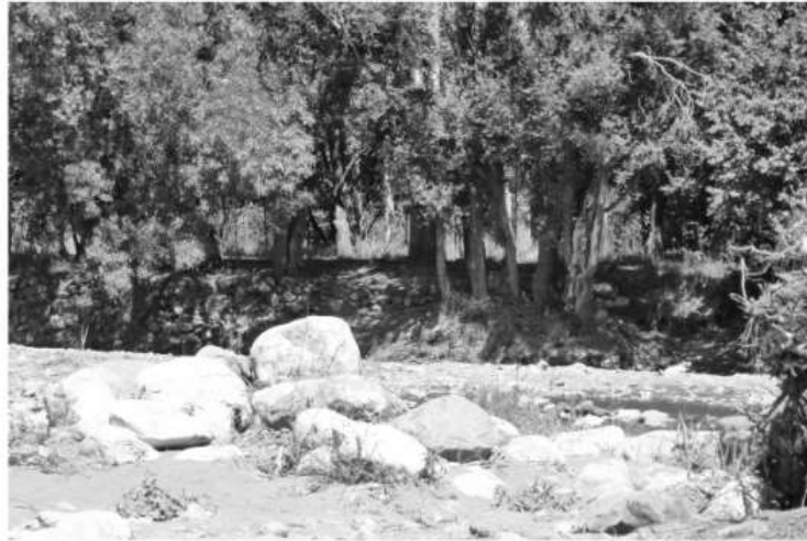
شکل ۴: احداث سنگچین ها در بازه سوم رودخانه (منبع: نگارندگان، ۱۳۹۶)
