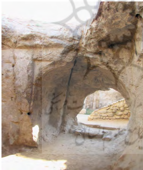
تصویر ۱۳. ورودی فضای V-2، گوشه‌سازی قاب درگاه با لایه نازکی از ملات (نگارندگان، ۱۳۹۸).
