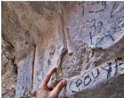
تصویر ۲۴. لایه ملات بر روی سنگ در قسمت مقرنس (نگارندگان، ۱۳۹۸).
