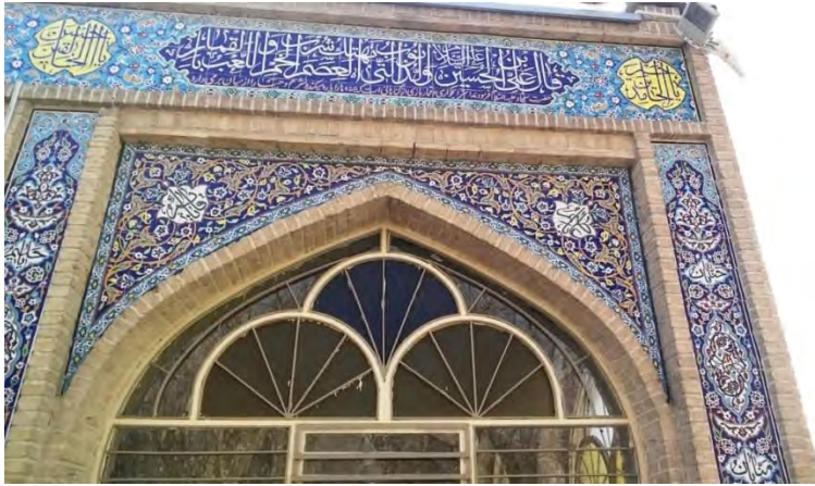
قسمتی از ضلع شمالی بنای بقعه
