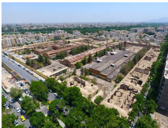
شکل ۹- نمایی کلی از کارخانه ریسایف اصفهان Source: Authors
