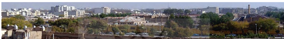
شکل ۶- نمای غربی کارخانه ریسباف
