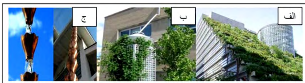
شکل (۵): الف) بام سبز ب) مخزن ذخیره آب باران ج) زنجیره باران
