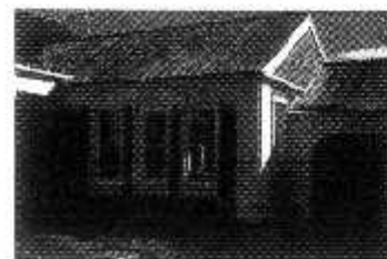
تصویر شماره ۱۷ - نمونه خانه‌های فردی پروژه مکزیک
