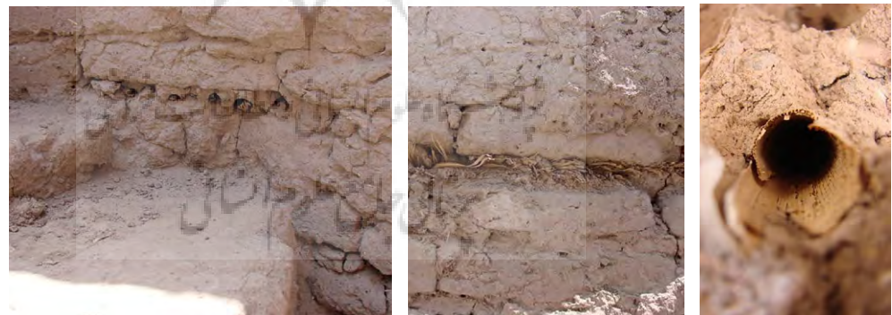
تصویر ۱۴: الف. مقطع یکی از نی‌های بین خشت‌ها که به قطر ۱/۵ تا ۲ سانتی‌متر است. ب. بدنهٔ داخلی عمارت سردر. ج. ردیف نی‌های به‌کاررفته در بین خشت‌های منار شرقی
