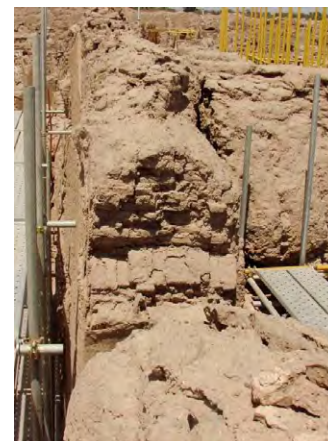
تصویر ۶: الف. رج های باقی مانده از خشت های طاق سردر کهن مسجد که داخل دیوار تراشیده شده شکل گرفته اند. ب. درگاه اصلی مسجد
