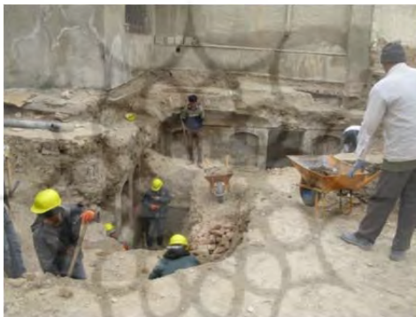
شکل ۲۳. ادامه خاکبرداری در قسمت‌های میانی و غربی فضای زیرزمینی خانه صلح.
