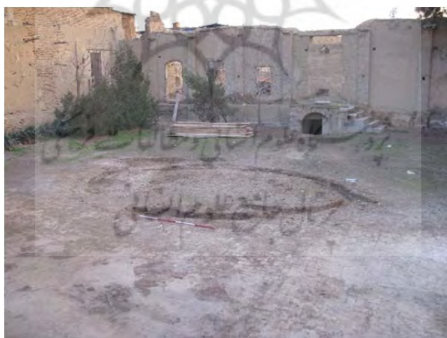
شکل ۱۲. مشخص شدن کف‌سازی آجری حیاط و حوض بیضی‌شکل در ابتدای عملیات خاک‌برداری در ترانشه ۴
