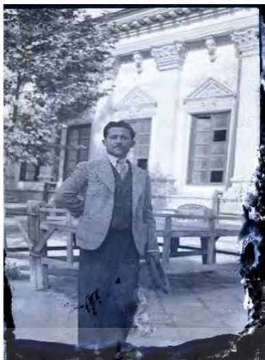
شکل ۵: نمای جنوبی ساختمان خانه صلح پیش از تخریب. (مأخذ: اسناد مکشوفه از خانه اتحادیه)
