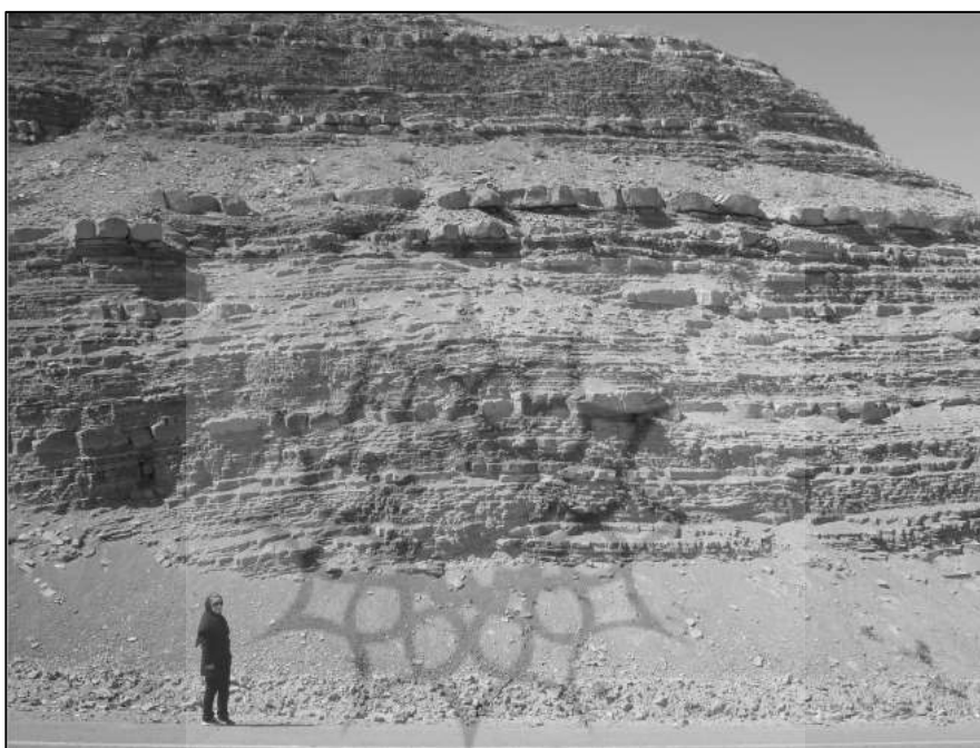
شکل ۱۲- وجود درزه‌های فراوان در دیواره‌های سنگی مشرف به جاده مواصلاتی
