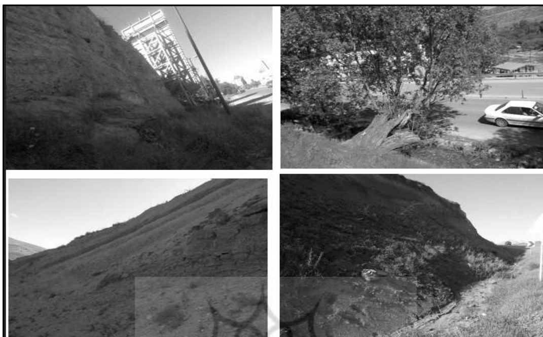
شکل ۱۰- وجود پدیده خزش و رسوبات آبرفتی سست با ارتفاع بیش از ۷ متر نزدیک به جاده مواصلاتی
