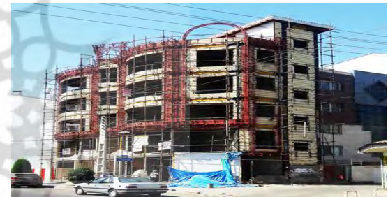
شکل ۵۰. مجتمع در حال ساخت و ساز در گل‌سار
