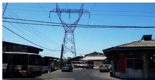
شکل ۱۰. دکل برق و ایستگاه اتوبوس
