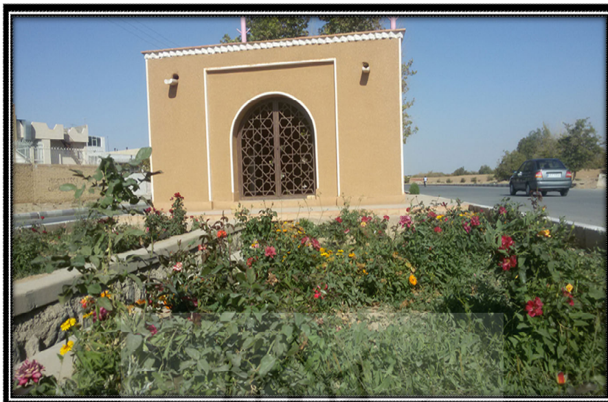
تصویر ۸- پنگ‌خانه خیابان جوی خارون (انتهای بلوار ولیعصر) باغ نو در نجف‌آباد اصفهان
