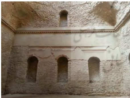
شکل ۲- گوشه‌سازی فیلهوش (به روش نمادین) در کاخ فیروزآباد فارس
