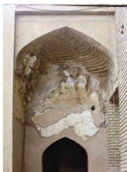
شکل ۱۲- مقرنس گلی به جا مانده از دوران آل مظفر در مدرسه شهاب الدین قاسم طراز
