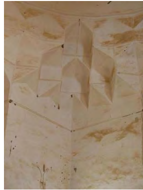
شکل ۲۵- پتکانه های گوشه سازی مقبره نشان از رواج ناحیه انتقال به سوی ساختارهای حجیم و فشرده بدون تزیین است.
