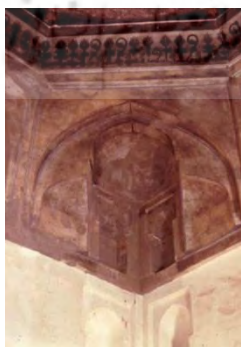
شکل ۱۱- گوشه‌سازی پتکانه مرکب بقعه دوازده امام یزد بصورت ترکیبی از نیم گنبد و تاقچه و لچکی.
