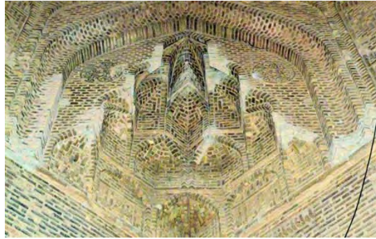
شکل ۱۳- معمار با قراردادن تویزه دوره بند در لبه گوشه‌سازی درگنبد مسجد گلپایگان توانسته کانه های آجری باربر را روی هم سوار کند.
