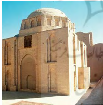
شکل ۱۶- مطبق بودن ناحیه انتقال در گنبد دوازده امام یزد از جمله راهکارهایی برای ممانعت از اعمال بار زیاد بر تویزه های باربر است.
