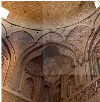
شکل ۳- در مسجد جامع اصفهان پتکانه آجری شامل سه لایه طاقچه کم عمق با پیلک، تاسه یا لچک ها و طاقک نهایی است که درون تویزه محفوظ شده اند.
