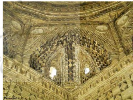
شکل ۱- گوشه‌سازی در گنبد امیراسماعیل سامانی بصورت تویزه لب بند با لنگه طاق پشتی بهمراه دو تاسه آجری در دو طرف آن می‌باشد.
