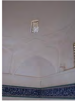
شکل ۲۲- گوشه‌سازی گنبد مسجد فیروزآباد میبد شامل اسکنج و لچکی بین آنها به‌همراه برنخش
