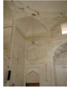
شکل ۲۱- گوشه‌سازی گنبد مسجد جامع اردکان بصورت اسکنج ساده با کاربندی بین آن‌ها
