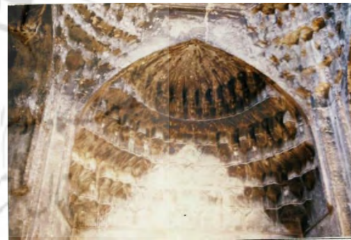
شکل ۱۵- سنت ساخت مقرنس های گلی در دوران آل مظفر در خانه برونی میبد نیز دیده می‌شود
