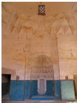
شکل ۹- گوشه‌سازی پتکانه مقبره مجموعه سلطان بندرآباد بصورت کانه کانه
