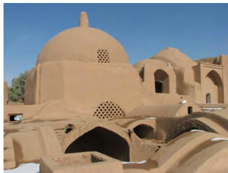
شکل ۷- در منظر بیرونی گنبد، معمار با بالا آوردن جززهای زمینه تا پاکار گنبد، ناحیه انتقال را پنهان نموده است
