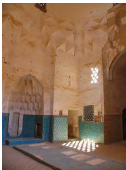
شکل ۸- فاصله بین گوشه‌سازی‌ها بوسیله لچکی ها پر شده است.
