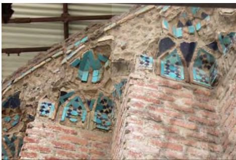
شکل ۱۲: کاشی‌کاری ساقه گنبد، (منبع: نگارندگان، ۱۳۹۶) دوره دوم ساختمان (ایلخانی) می‌داند (سیرو، ۱۹۴۱: ۱۸۴) (شکل ۱۲).
