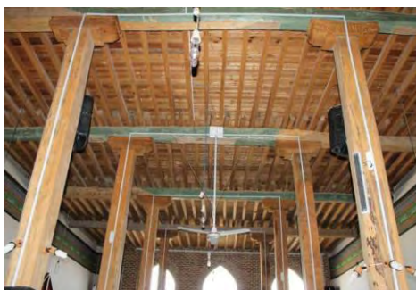
شکل ۶: داخل مسجد با ستون‌های چوبی و سقف تیرپوش، (منبع: نگارندگان، ۱۳۹۶)
