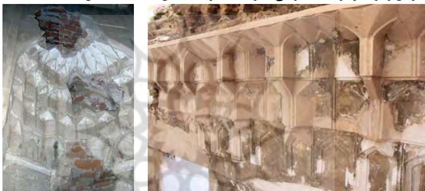
شکل ۱۵-۱: مقرنس کاری بالای محراب که دارای قطاربندی نیز می‌باشد، (منبع: سعادت‌ی و سعادت‌ی، ۱۳۹۴: ۱۴)
