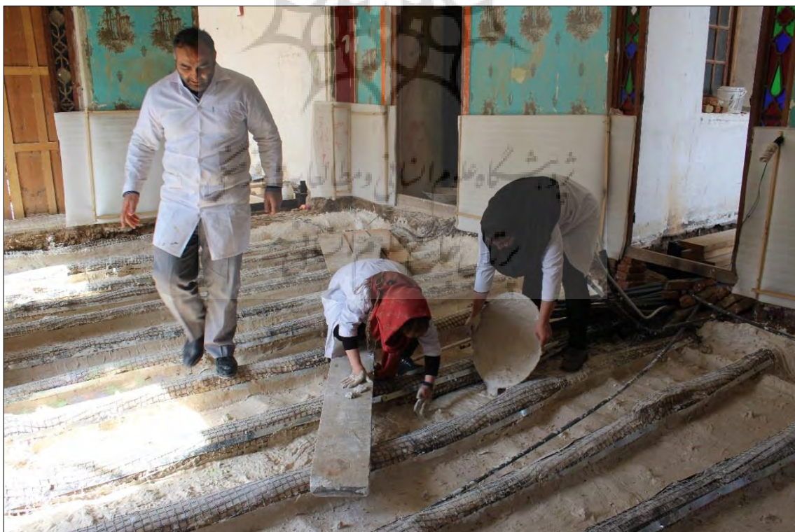
شکل ۳: اجرای تخته‌گچی در بین تیرپوش‌های سقف اتاق سفره‌خانه عمارت سردار ماکو
