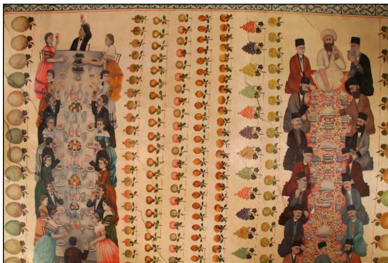
شکل ۱: نقاشی‌های سقف اتاق سفره‌خانه که آسیب‌های ترک، طبله باعث جدایی لایه اجرایی گردیده است
