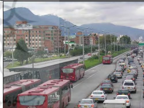
شکل ۹. وجود خط سبقت در ترانس میلان بوگوتا
